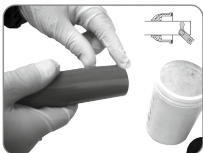
Lubrique la parte exterior del tubo
